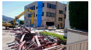
益城町役場 (外壁と駐車場の補修工事中)
